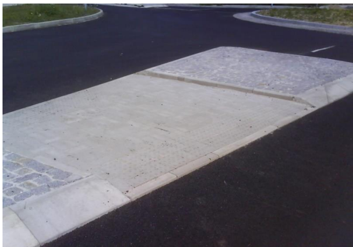
Příklad řešení ostrůvků ze zešikmených obrubníků (zde betonových)
